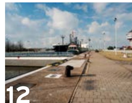
Nieuwe sluis in Terneuzen.
